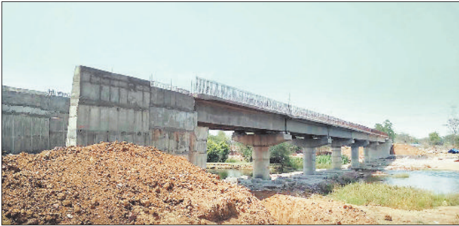
आधा अधूरा पुल निर्माण का कार्य।
